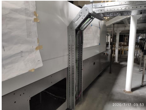
Figura 4. Fotografías en implementación de la línea de llenado y pruebas a cableados, 1
