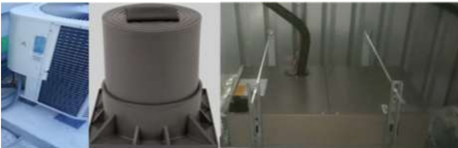
Figura 45. Fijación de unidades condensadora y manejadora
