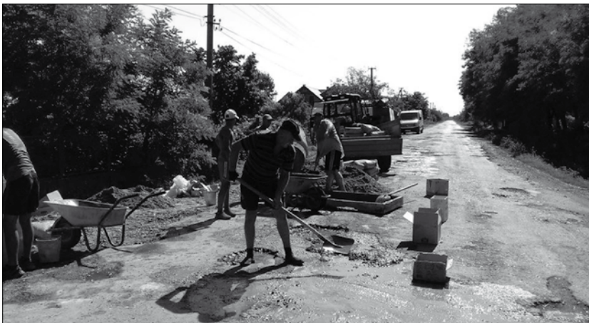
2. kép Nagypalád, 2019. A lakosok a Nagypalád–Fertősalmás közötti közutat javítják (betonozzák). Fotó: Bíró Vencel.
