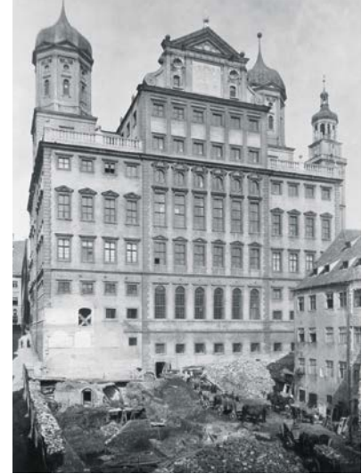
Abbruch des Eisenhofes Foto vermutlich von F. Brauer, 1882, Quelle: Stadtarchiv, Sign.-Nr. FS FA E 498
