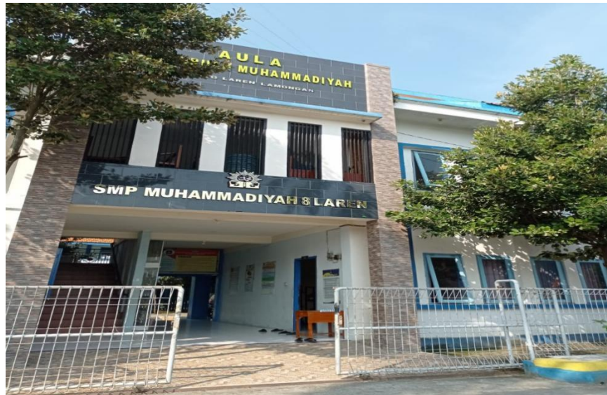
Gerbang Depan Dan Pintu Masuk SMP
