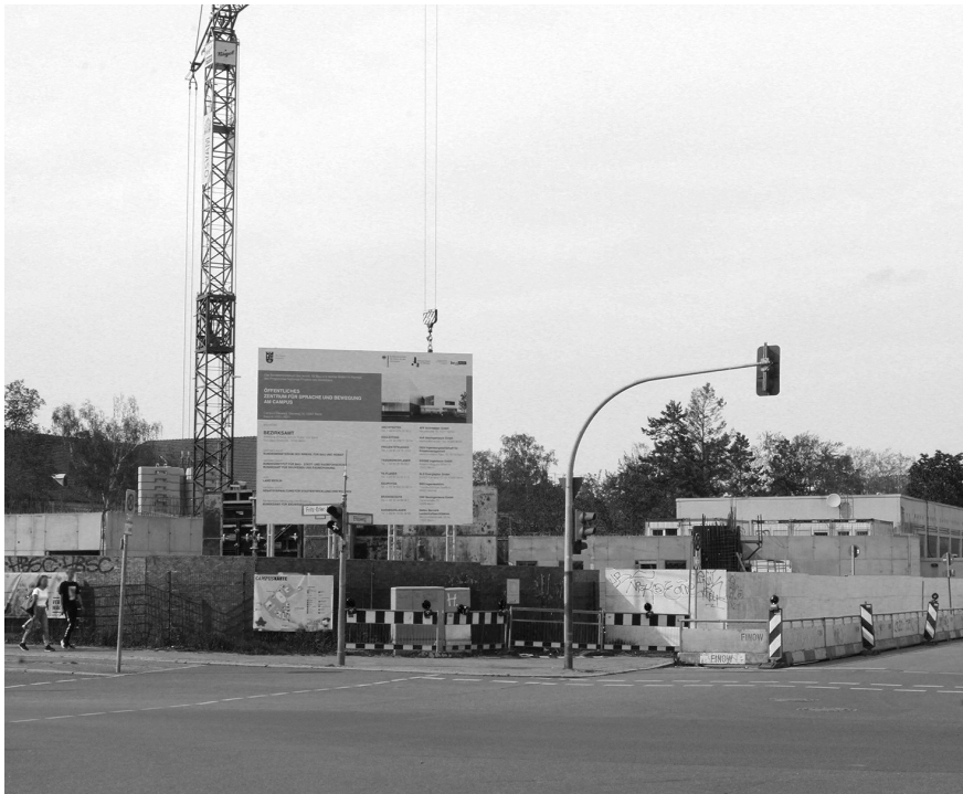
Abb. 3: Baustellensituation auf einem Campus
