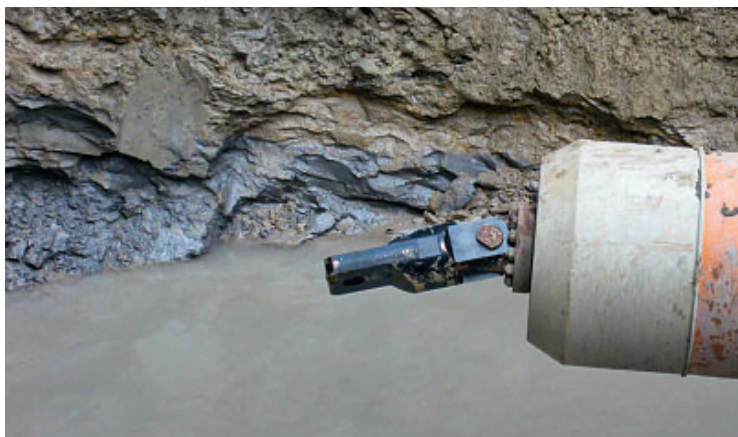
Tafel 1, Foto 4: Detail von Foto 2 links unten und Foto 3 rechts unten anschliessend. Beige-grau gebänderte tonige Siltschicht zwischen vorbelasteten Kiesbänken gelagert. Kiesbänke dicht in tonig-siltige Matrix gepackt wie Grundmoräne.
