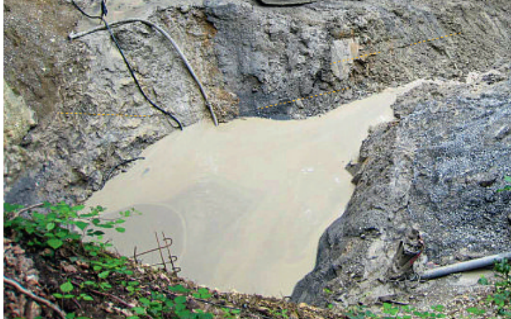
Tafel 1, Foto 2: Zielschacht Westseite. Wechsellagerung von tonig-siltigen Kiesbänken mit Lehmlagen, beige- bis schwarzgrau gebändert, Schichtung flach gegen rechts (See) einfallend.
