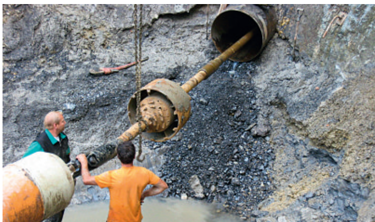
Tafel 1, Foto 3: Zielschacht Rohrvortrieb Nord, Baugrubenabschluss Süd unter Foto 1 anschliessend. Chaotisch gelagerte (? Glazialtektonik) Kiesbänke und Lehmlagen, beige- bis schwarzgrau gebändert.
