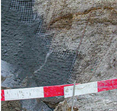
Tafel 1, Foto 1: Baugrubenabschluss Süd. Glaziale Schotter im Hangenden der See-sedimente mit diskordanten Mergellagen und Verwitterungshorizonten, vermutlich Münsingen-Schotter bzw. sog. Spiezer Schwankung.
