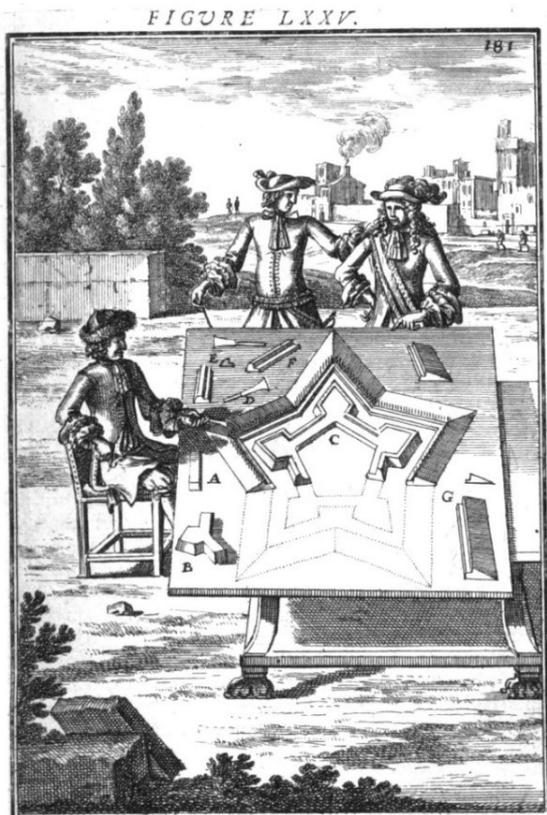
Abbildung 60: Ein aus Holz gefertigtes Modell einer Festung mit fünf Bastionen (Manesson-Mallet 1671, S. 181)
