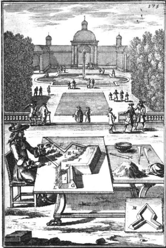
Abbildung 57: Bau des Modells einer Bastion aus Ton (Manesson-Mallet 1671, S. 175)
