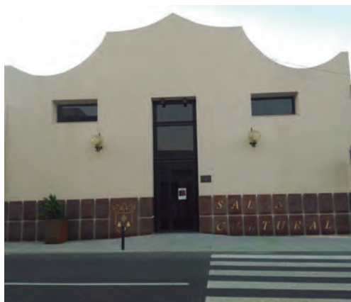
Imagen 40. Fachada remodelada del Salón Cultural. 2018. Foto de elaboración propia.
