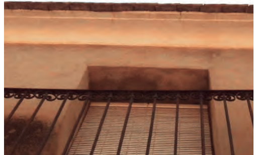
Imagen 32. Cornisa con alero de moldura. 2018. Foto de elaboración propia.
