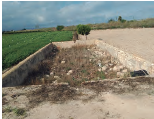
Imagen 14. Panorámica de la balsa. Elementos de toma de agua y salida de excesos. 2018. Foto de elaboración propia.
