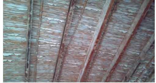
Imagen 28. Entramado de cañizo usado como soporte de las tejas de la cubierta. 2018. Foto de elaboración propia.
