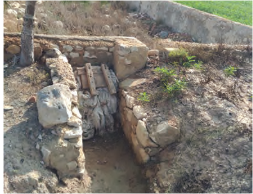
Imagen 13. Salida de agua para vaciado y limpieza. 2018. Foto de elaboración propia.
