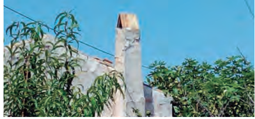
Imagen 29. Chimenea común rematada con la típica cubierta de dos tejas. 2018. Foto de elaboración propia.
