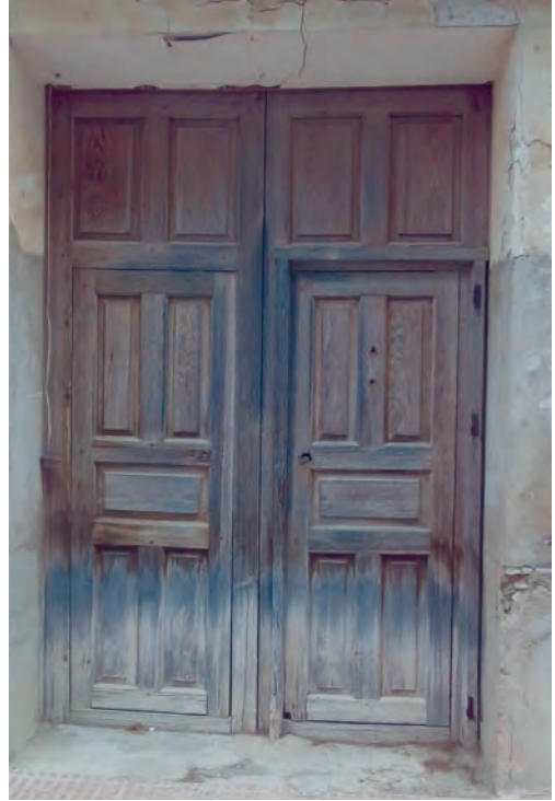
Imagen 38. Puerta compuesta por casetones. 2018. Foto de elaboración propia.
