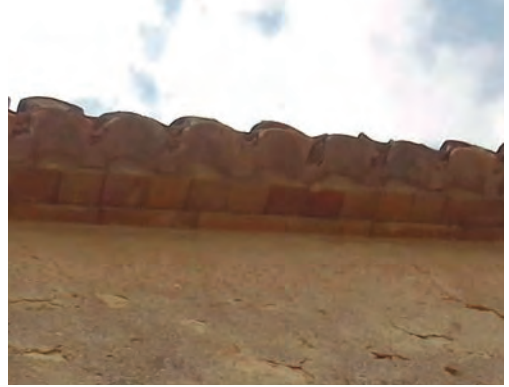
Imagen 31. Cornisa con alero de doble hilada. 2018. Foto de elaboración propia.
