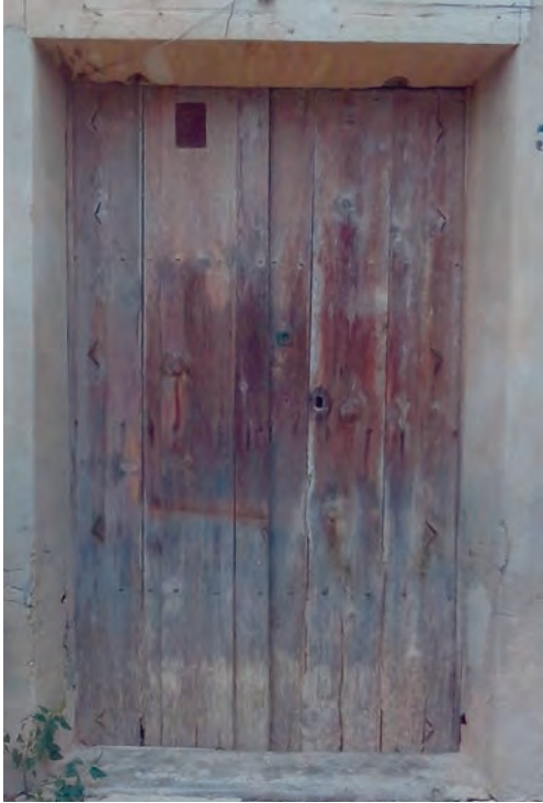
Imagen 37. Sencilla puerta formada por listones verticales. 2018. Foto de elaboración propia.
