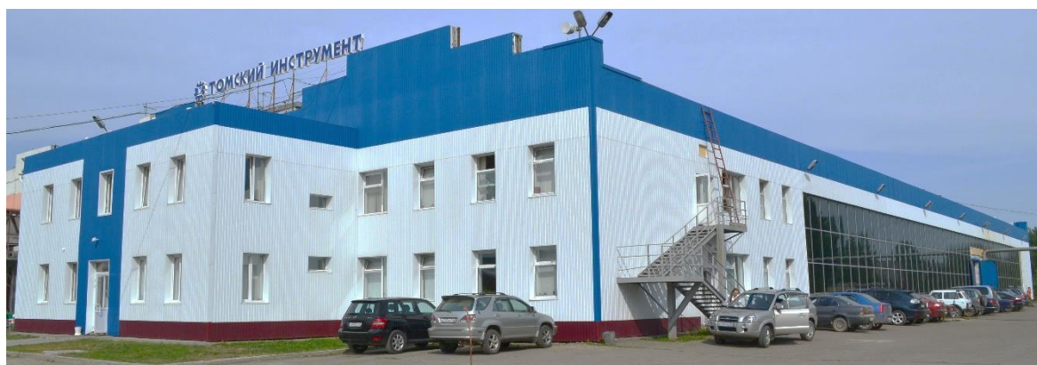
Корпус № 1. Со стороны проходной.
