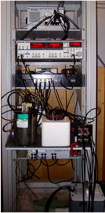
Fig. 3. Picture of the generating bridge developed at the Istituto Nazionale di Ricerca Metrologica.
