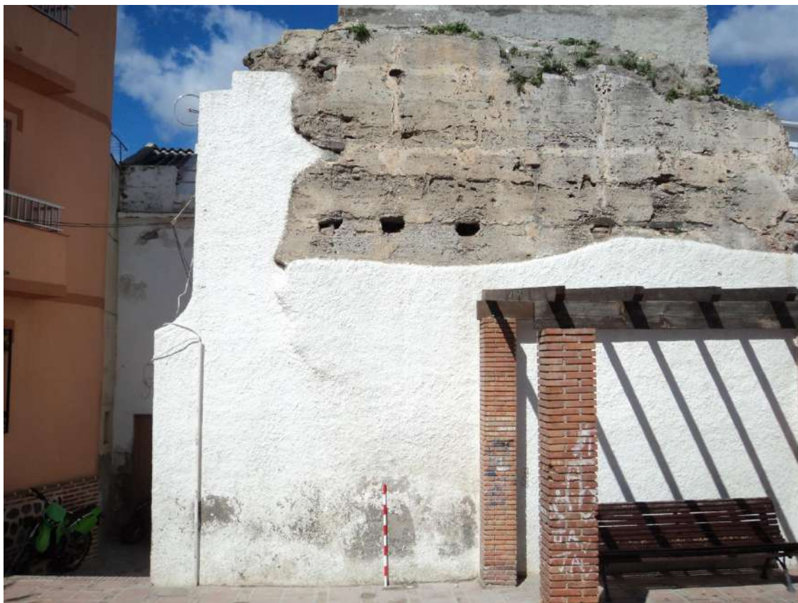
Fig. 17: tapial calicastro en plaza Eras del Castillo Fuente propia
