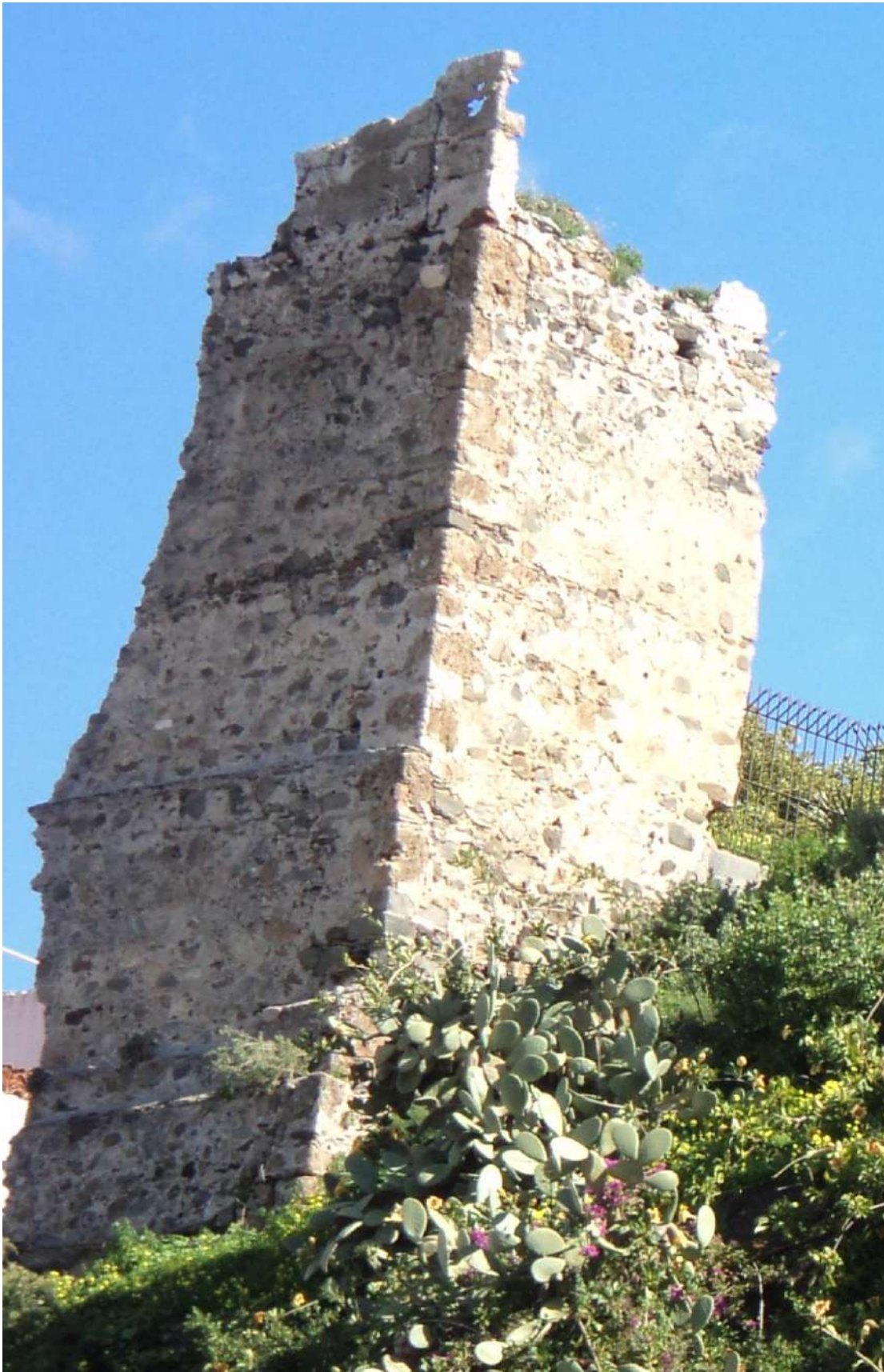
Fig. 19: sillares de gran tamaño en las esquinas de la torre vista desde el Majuelo
