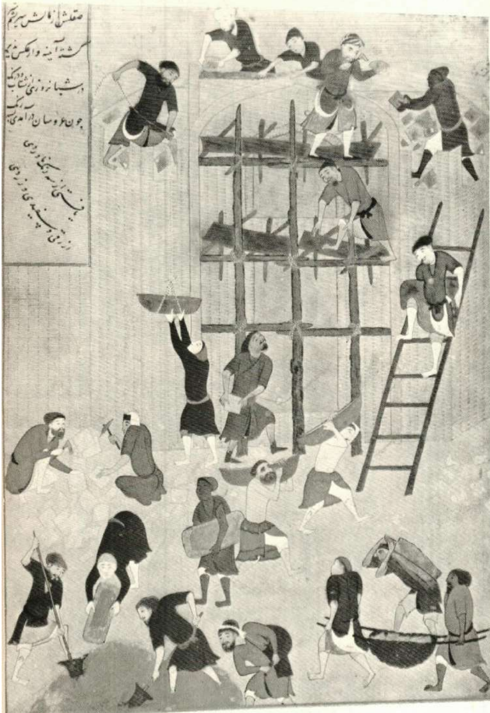
Fig. 38: Andamio y trabajos previos
