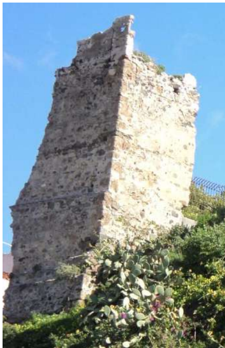
Fig. 21: mampuestos con separación de ripios vista desde el Majuelo Fuente propia
