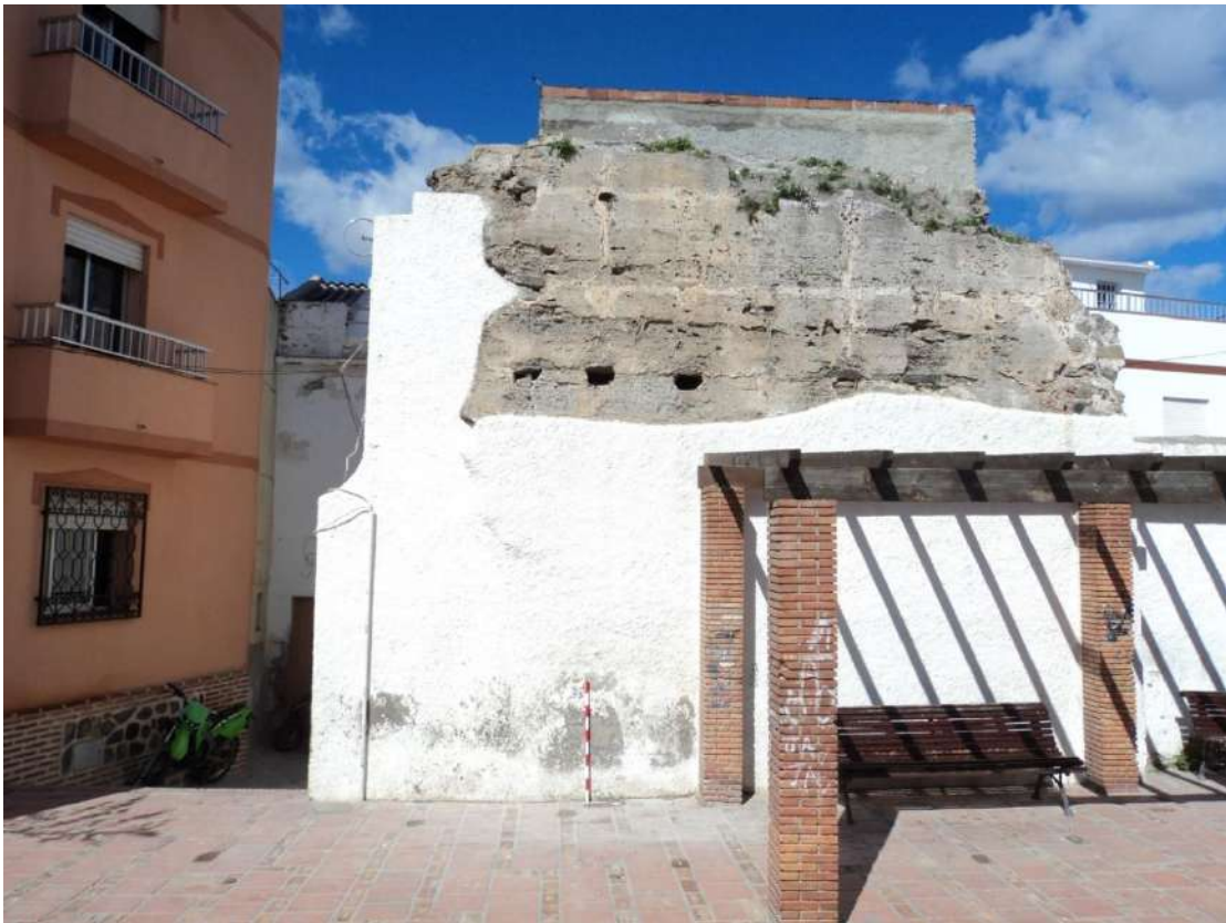
Fig. 64: Tramo de muralla en la Plaza Eras del Castillo
