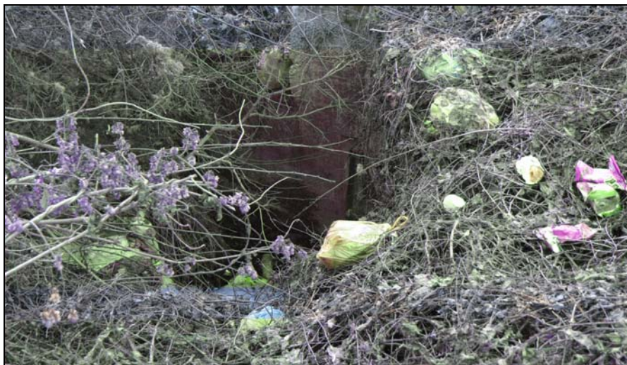
Слика 2. Запушен пропусник у насељу Шуљковац. Клизиште КБ 149
