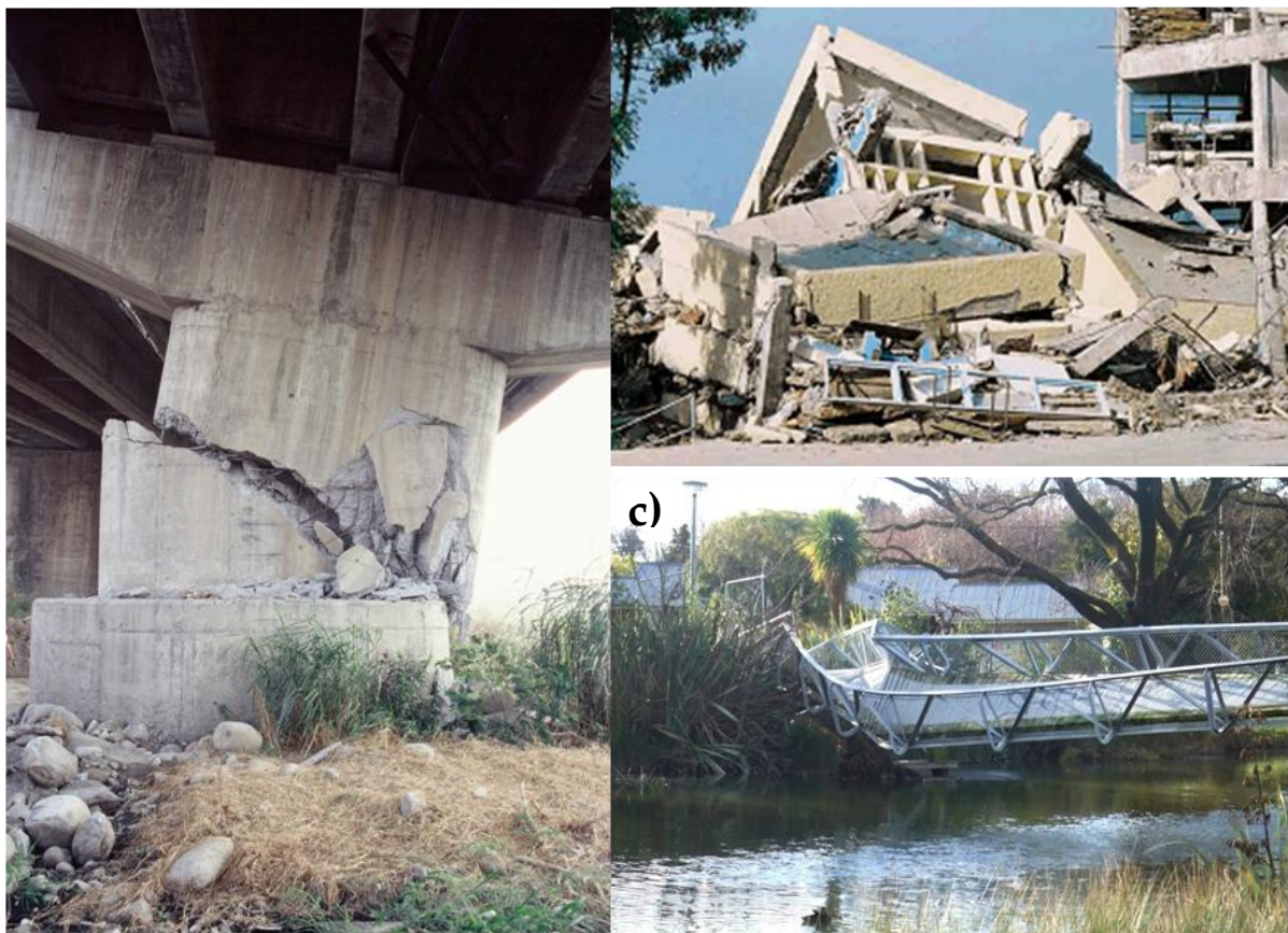
Illustration 1 : Pile de pont détruite séisme de Chi-Chi (Taiwan) 1999 (a), bâtiment détruit séisme de Boumerdès (Algérie) 2002 (b), passerelle détruite séisme de Christchurch (Nouvelle-Zélande) 2011 (c).
