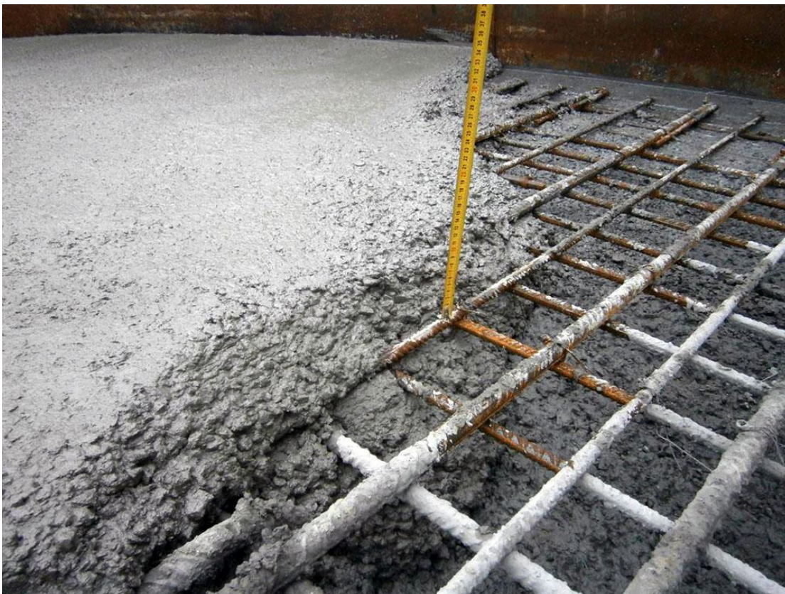
Figure I-1 : Photo de la mise en œuvre d'une dalle en béton armé
