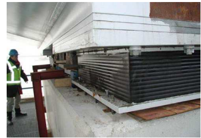
(c) Appuis parasismiques réels, Pecker, 2010a
