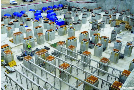
(b) Appuis parasismiques réels, Cahiers, 2011
