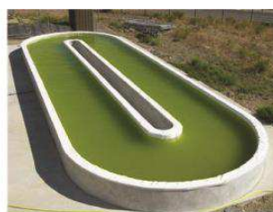
Un raceway pilote de laboratoire (INRA de Montpellier)
