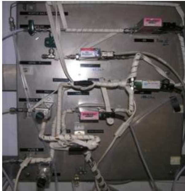
Figure 150. Vue de la rampe de dilution.
