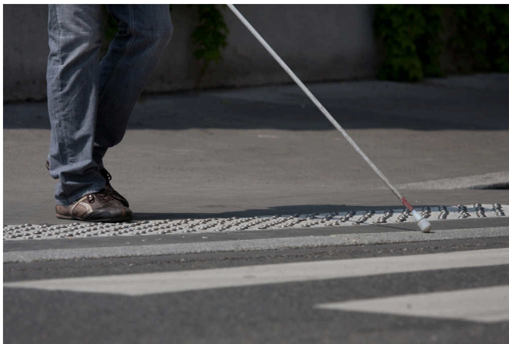
Figure 20 : Bande d'éveil de vigilance aux abords d'un passage piéton
