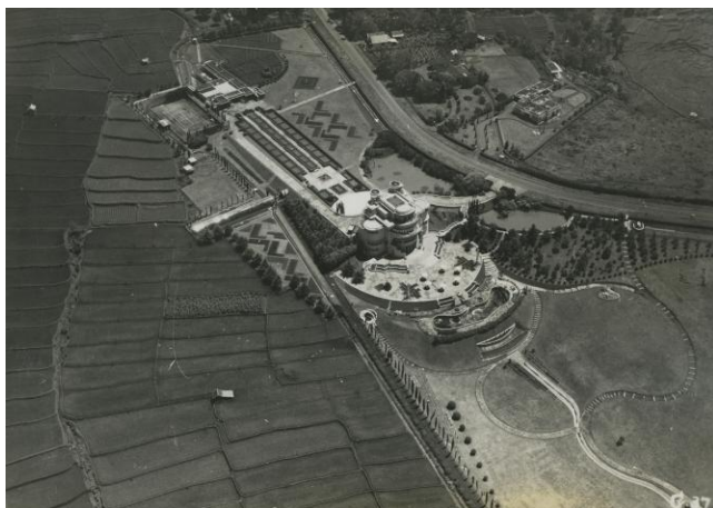
Luchtfoto van 'Villa Isola' en het landgoed (collectie KITLV)
