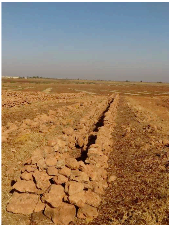
Figure 50. Photo de tunnels avant remplissage Réalisation : Gameroff et Pommier
