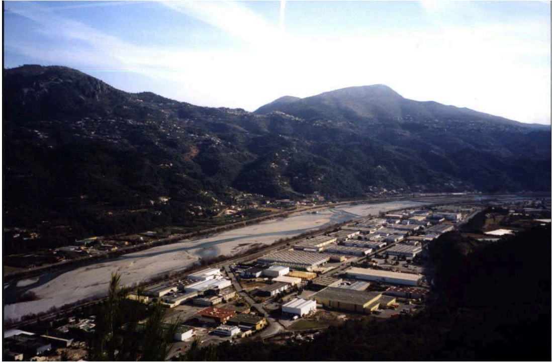
Fig. 2.4 : Les endiguements le long de la vallée du Var
