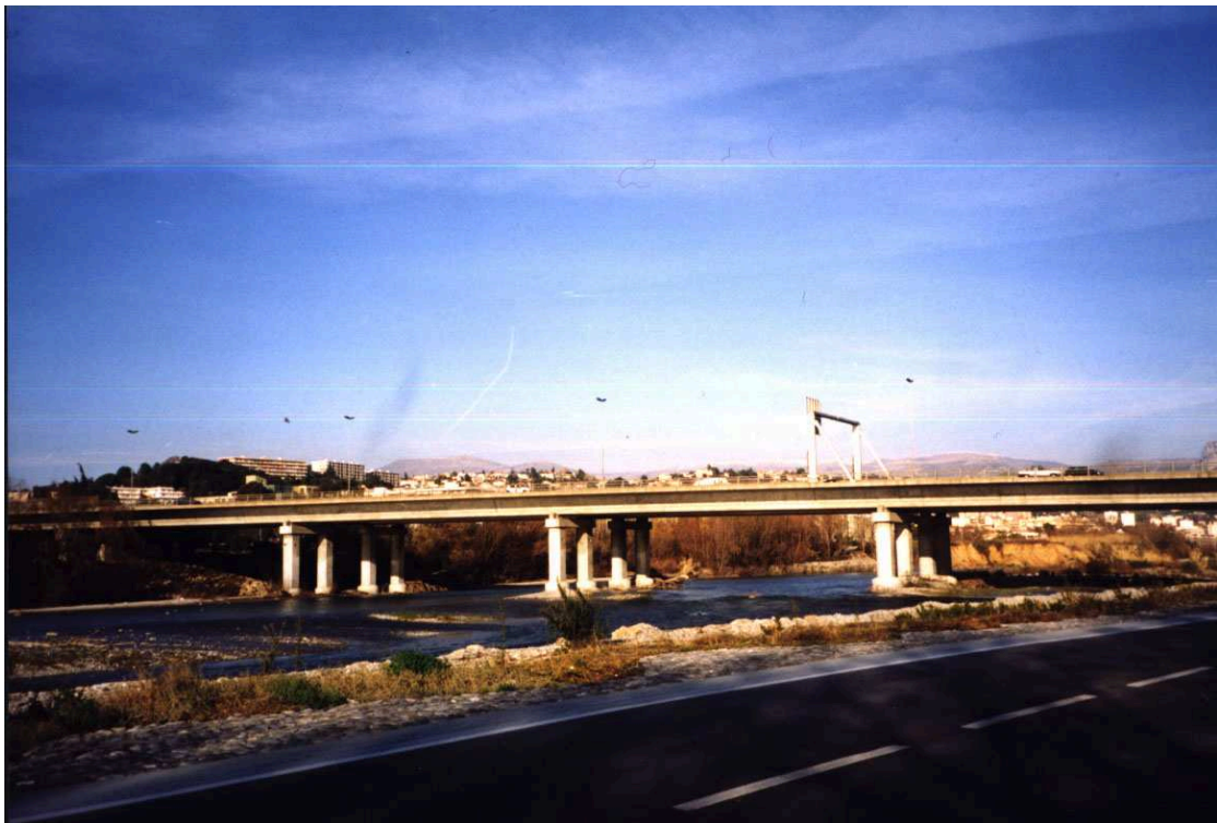
Fig. 2.5 : La largeur du lit à l'aval
