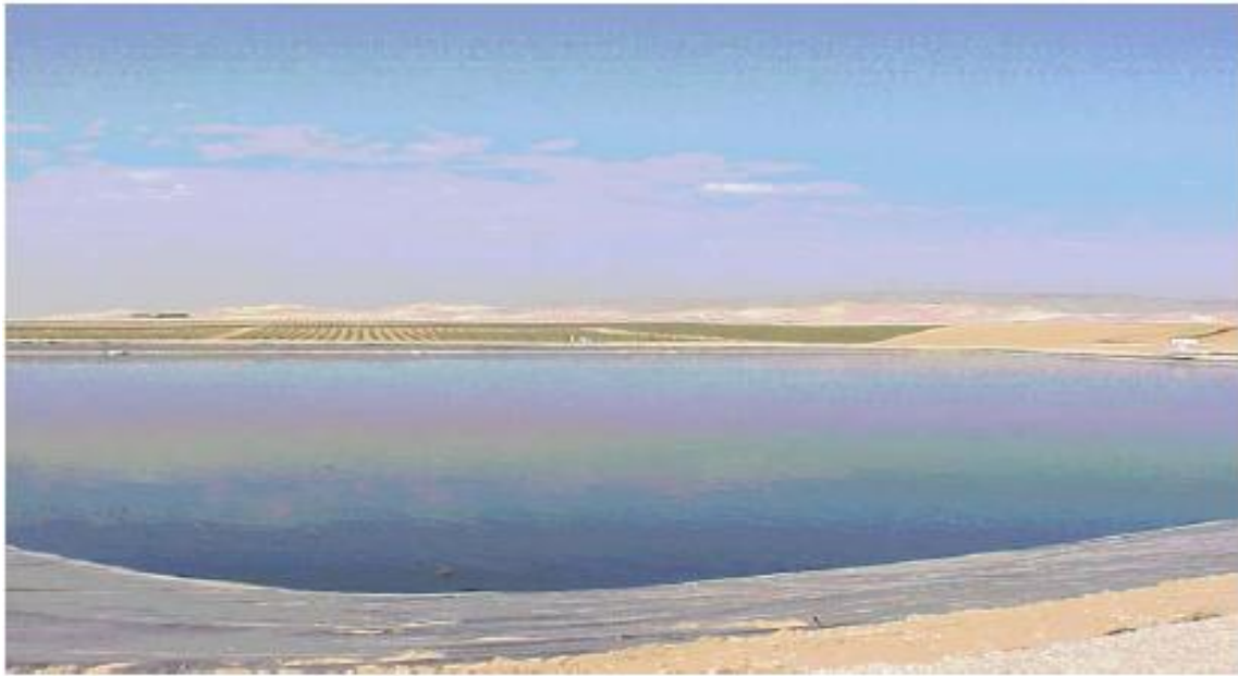
Photo 4 : Réservoir de stabilisation de Arad (Israël)
