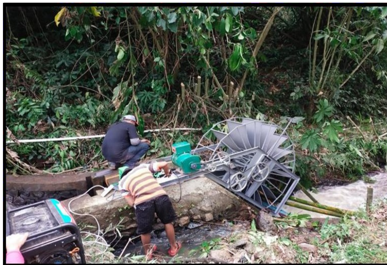
Gambar 2. Proses Pemasangan Kincir Air Mikrohidro oleh Mitra Pendampingan
