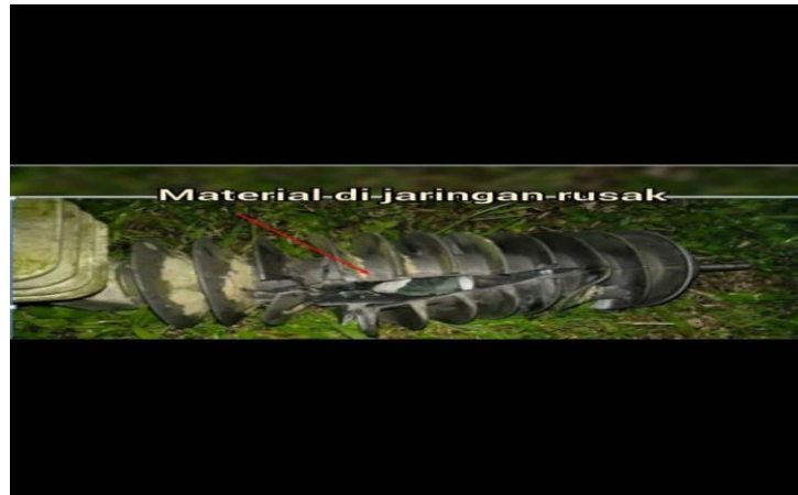
Gambar 2 Material di jaringan Rusak.
