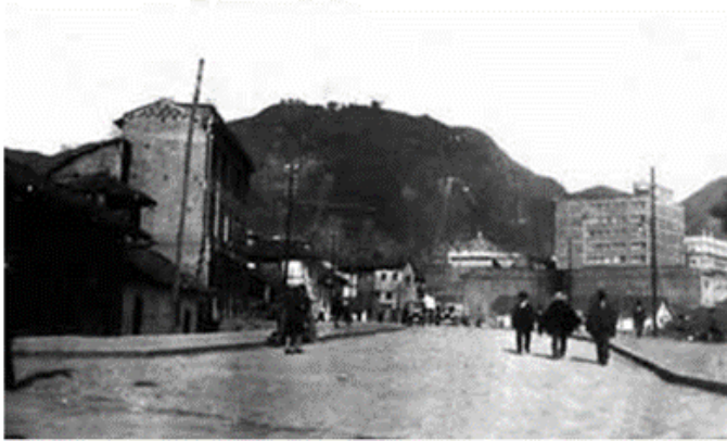
Figura 9 – Río san Francisco canalizado y adecuado como vía (1930)
