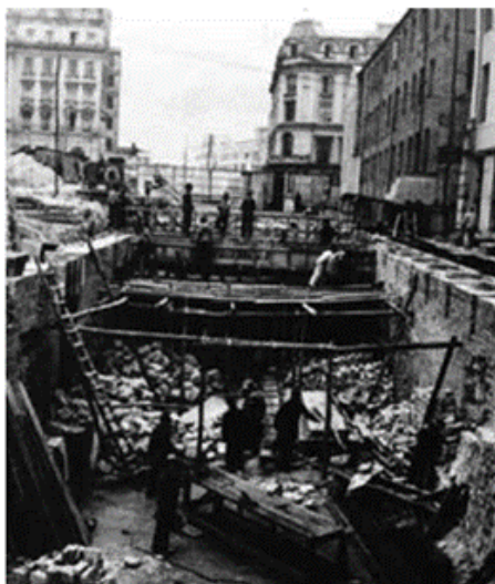
Figura 8 – Canalización Río San Francisco (1920)
