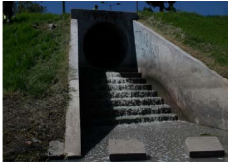
Figura 11 - Intervenciones hidráulicas Río Juan Amarillo
