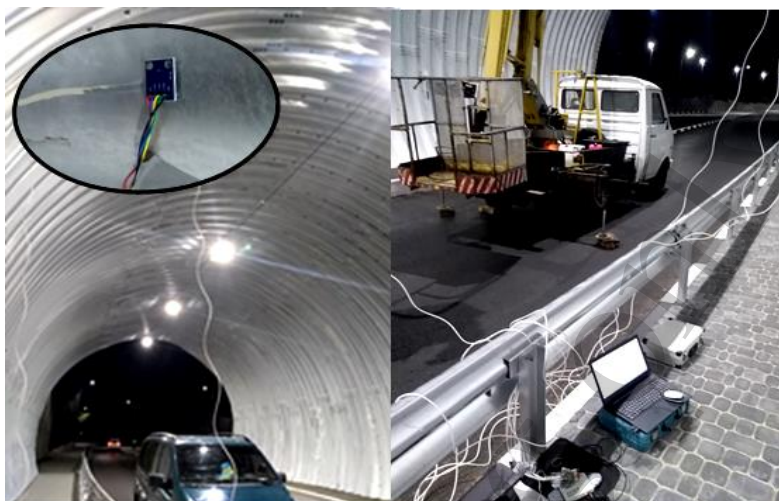
Рис. 4. Інерційні експериментальні випробування тунельного шляхопроводу із збірних металевих гофрованих конструкцій
