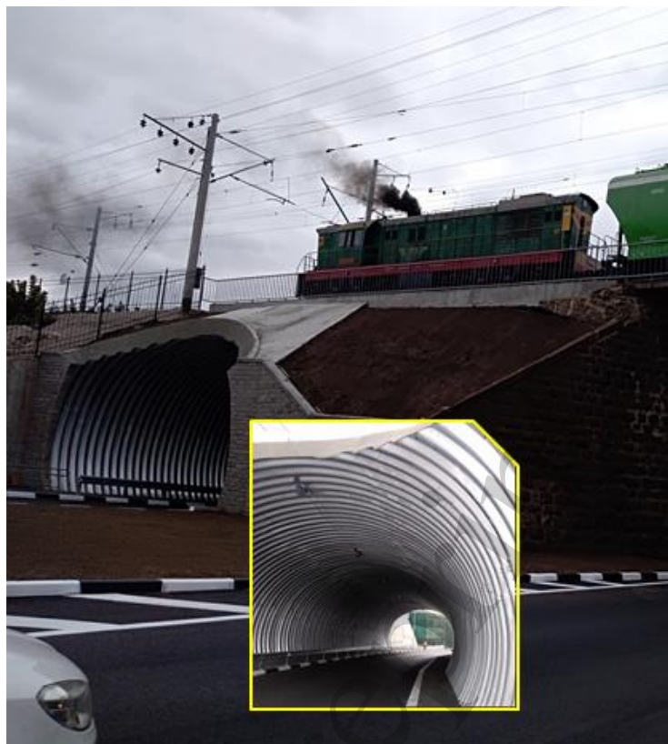
Рис. 1. Вигляд тунельного шляхопроводу із збірних металевих гофрованих конструкцій під залізничною колією
