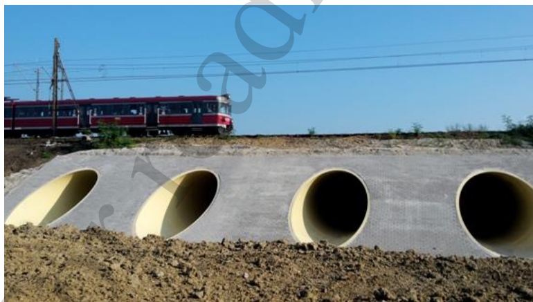
Рис. 1. Процес експлуатації склопластикових труб у тілі насипу залізничної колії [1]
