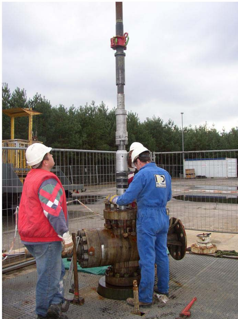
Abb. 29: Einbau des Packers für den Tiefenzirkulations-Test
