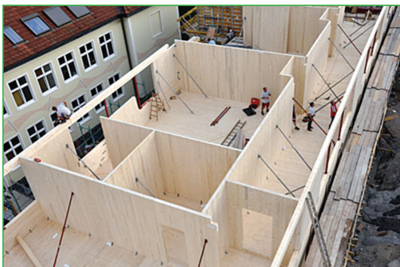
Figura 4: Edificio en proceso de construcción con CLT.
