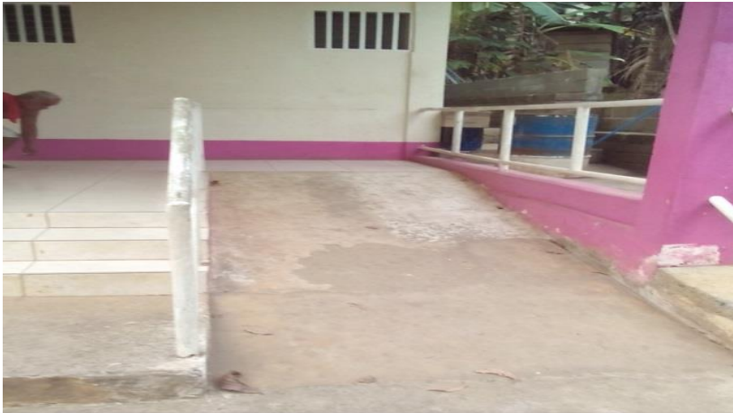
Rampas del Instituto Nicaragüense de Seguridad Social muy inclinada para las personas de silla de ruedas. Tomada por Mina L. Fecha 24/04/2016.
