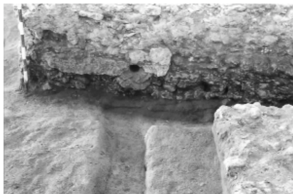
Figura 10. Termas. Desagüe y canalización de la piscina del frigidario (primera ampliación de los baños).
