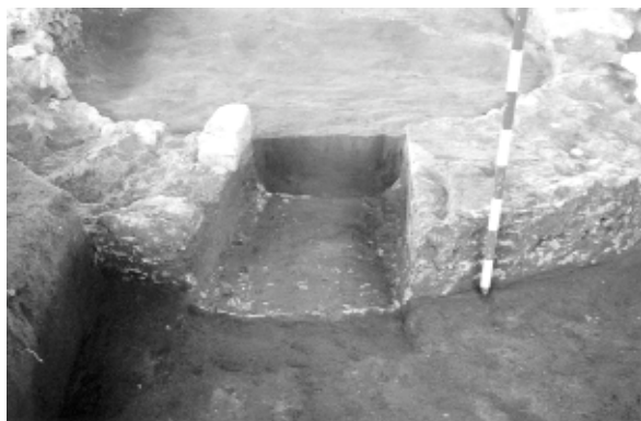
Figura 20. Zona fría de las termas (ampliación final). Sistema de aireación y drenaje de humedades en los cimientos de la estancia 47.
