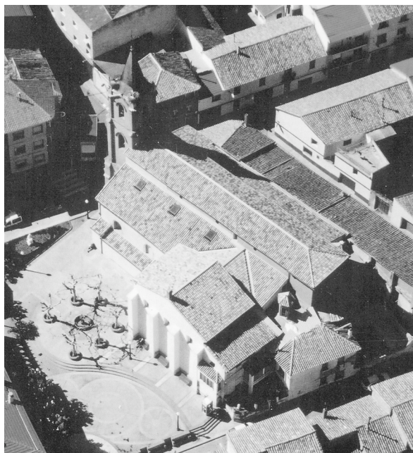
Figura 6. Vista de pájaro de la iglesia de San Pedro. En la actualidad, las construcciones adosadas a los ábsides han sido eliminadas con objeto de la restauración y puesta en valor de éstos; también las adosadas al muro norte, donde se ha construido el museo parroquial.
