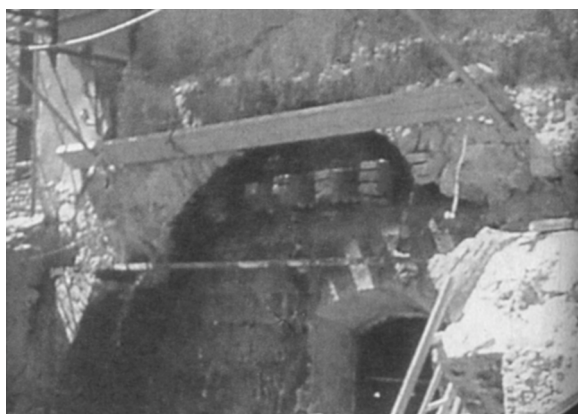
Figura 4. Detalle de los canetes de tradición musulmana descubiertos durante las obras de 1998. (Según San Martín, A., Zuera la Villa desconocida , p. 56).
