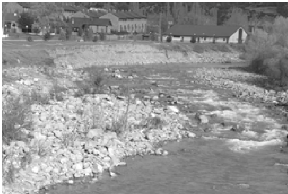
Figura 14. Margen erosionada en Villanúa, afectando directamente a una urbanización construida en el espacio fluvial.
