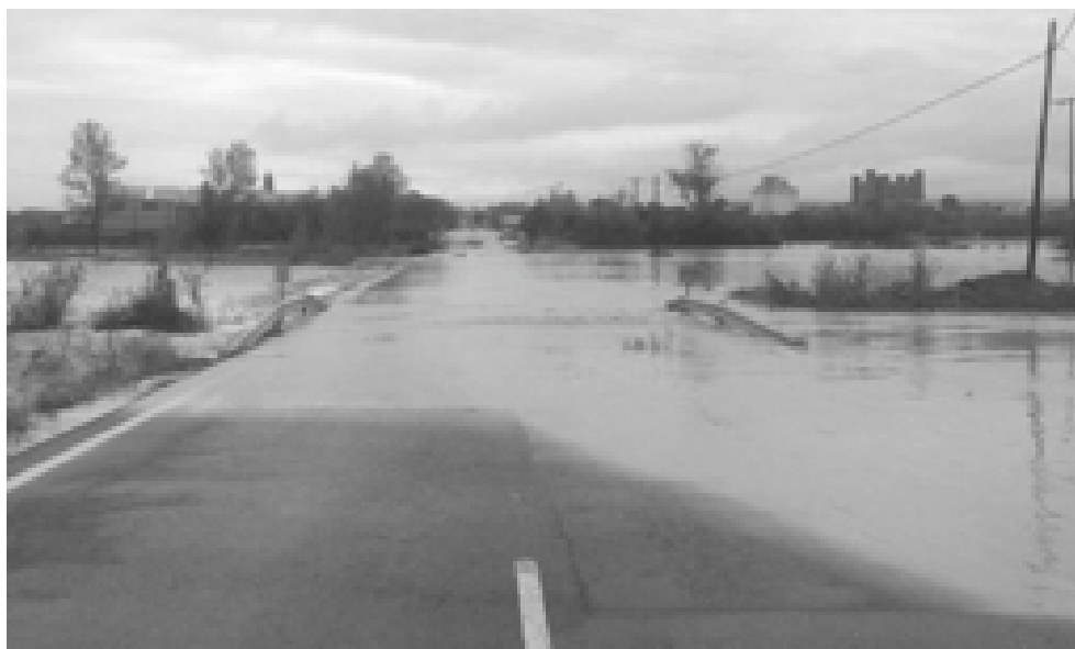
Figura 9. La carretera A-127 cortada a la entrada de Sádaba.
