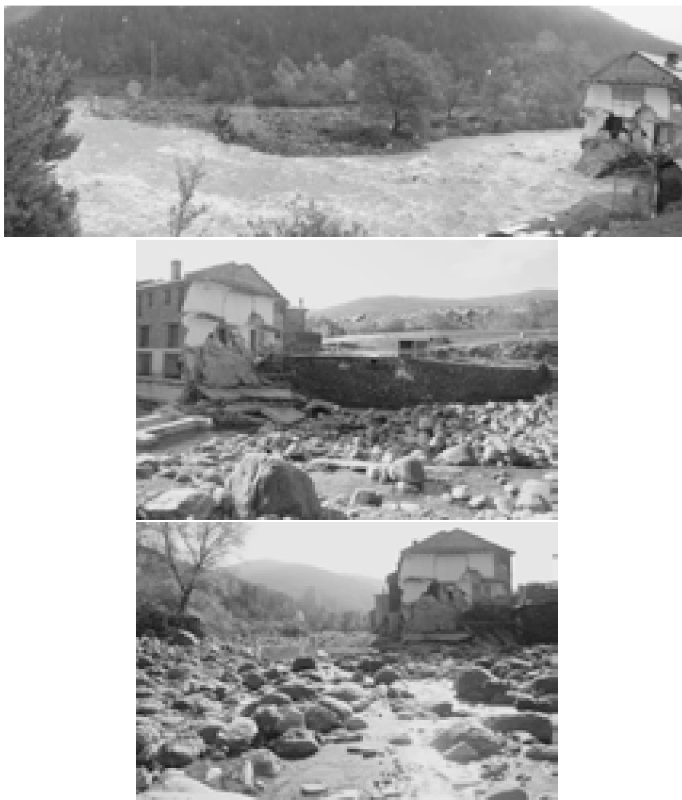
Figura 10. Tres perspectivas del unifamiliar construido en el cauce y destruido por la crecida. La primera imagen está tomada antes del desvío del cauce por la C.H.E., las otras dos son posteriores a la fase inicial de las obras.
