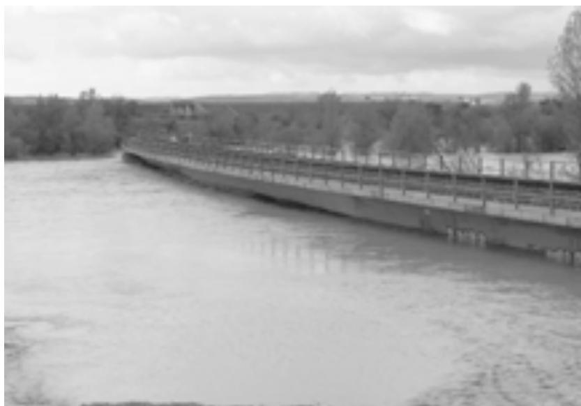
Figura 15. La corriente del río Gállego chocando contra el tablero del puente del ferrocarril de la papelera Montañanesa el 21 de octubre.
