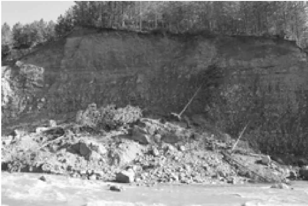
Figura 12. Deslizamiento en la margen izquierda del río Aragón aguas arriba de Castello.
