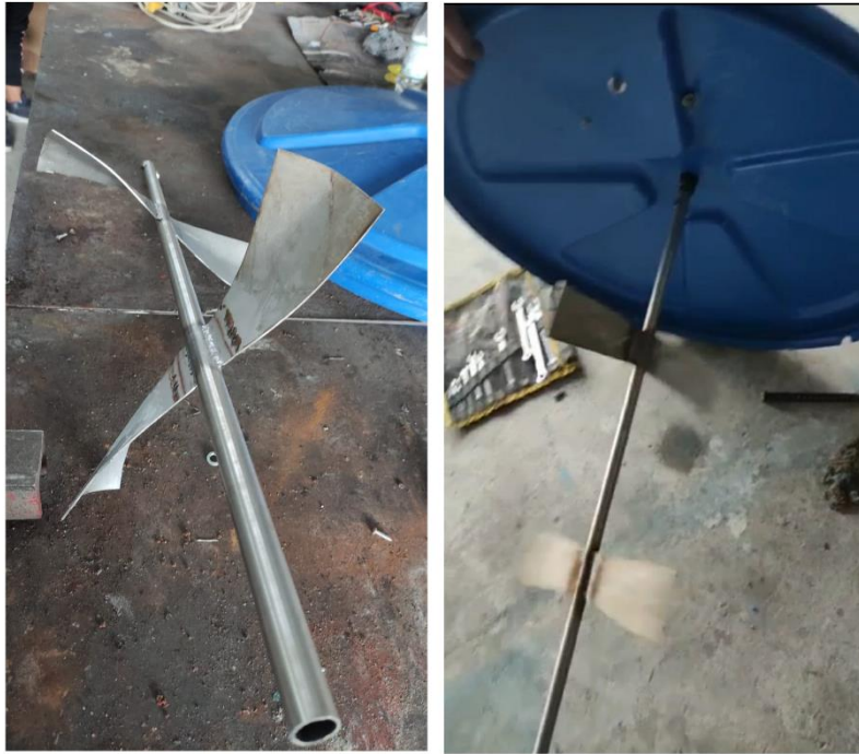
Figura D. 2. Adaptación e instalación de la paleta de mezclado
