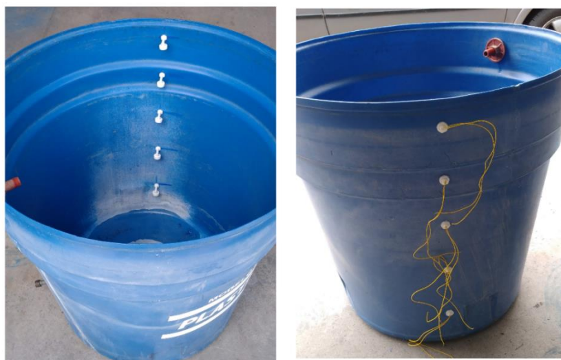
Figura 5. 2. Instalación de los sensores de nivel de agua ZPC1 en el tanque.
