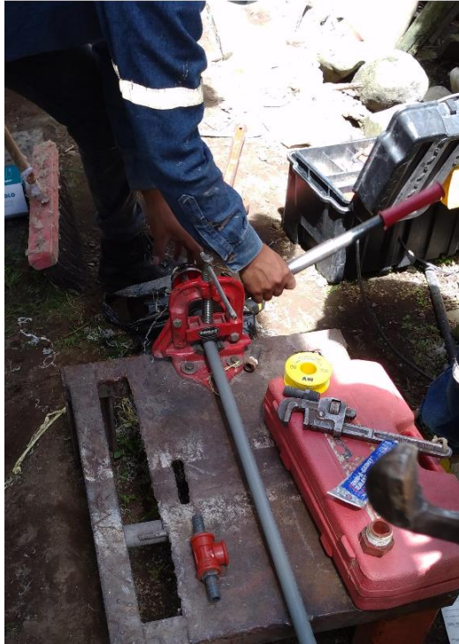
Figura C. 4. Realización de la rosca para la unión de tubería
