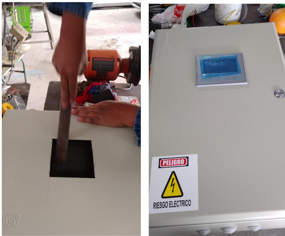
Figura E. 1. Montaje de la pantalla HMI
