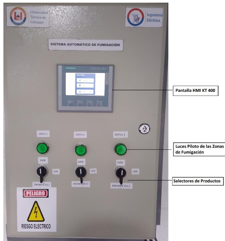
Figura F. 1. Tablero Control del sistema automático de fumigación.
