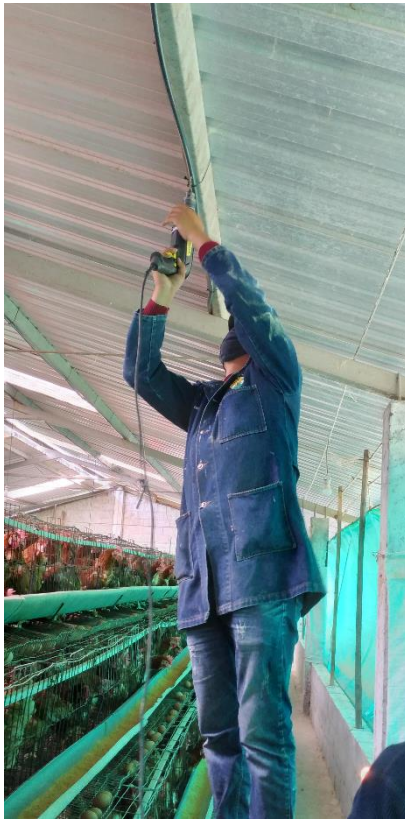
Figura C. 2. Perforación de la manguera para la instalación de los nebulizadores.
