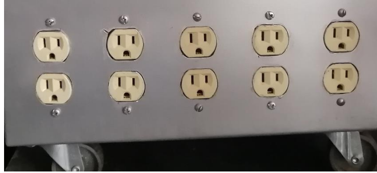
Figura 5.6. Conexión de los tomacorrientes dúplex.
