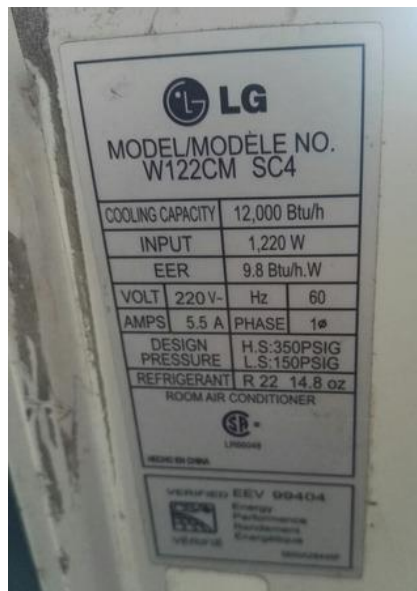
Figura 19. Identificación del acondicionador para aire tipo ventana
