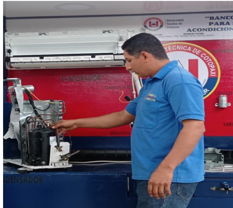
Imagen 12 Ubicación de la unidad condensadora del equipo tipo Split Fuente: Giler Henry (2021)
