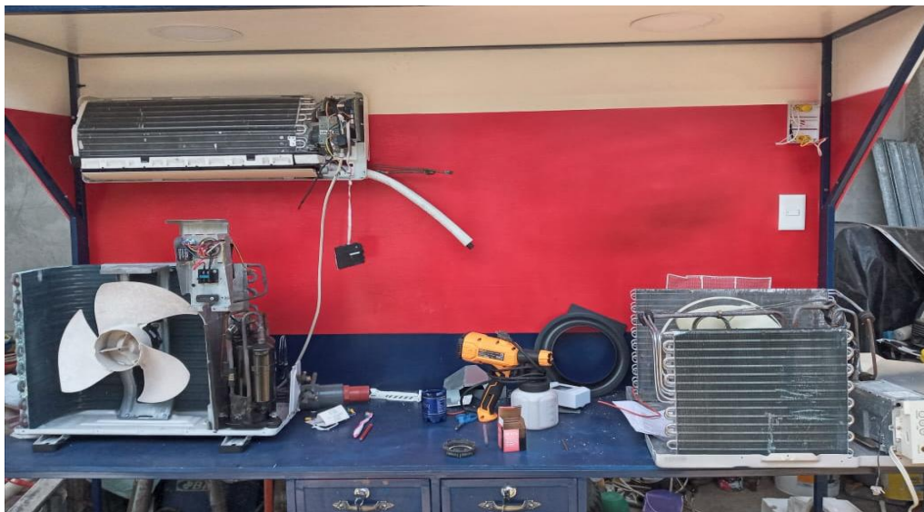
Imagen 3. Instalación del Banco de pruebas.
