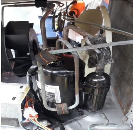
Imagen 2. Motor compresor de 12000 BTU
