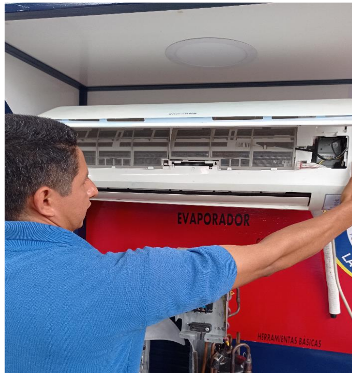
Imagen 8 Instalación del evaporador del Split Fuente: Giler Henry (2021)
