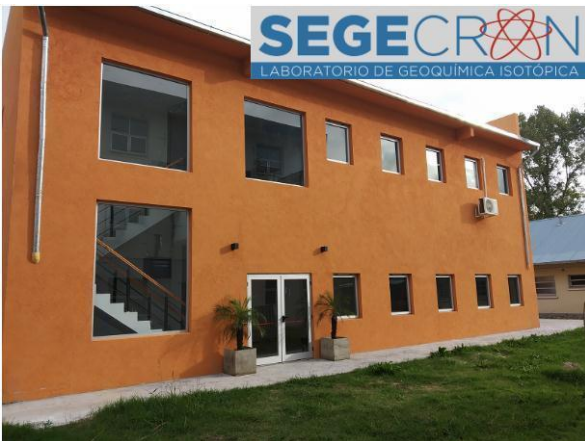
Figura 1.1. Vista del edificio del SEGECRON.
