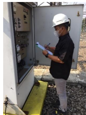
Gambar 4. CBM IL1 pengecekan tekanan pneumatik PMT dan counter
