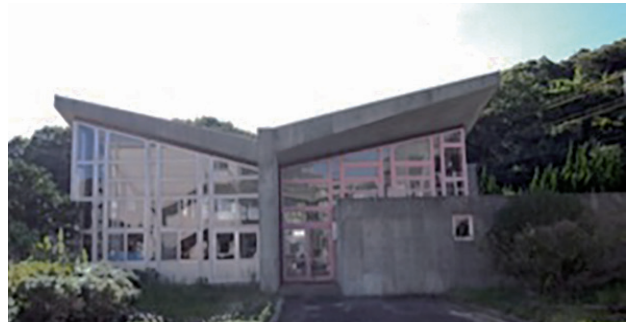
図6 瀬戸幼稚園 後ろの山の斜面と同じ角度の屋根 右手の長方形部分が玄関からホールに続く廊下
