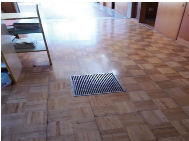
図10 瀬戸幼稚園 床にある引き上げ式の蓋
