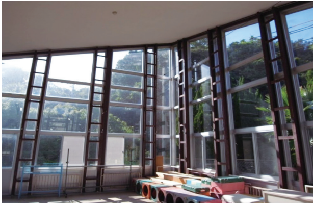
図9 瀬戸幼稚園 ホールのガラス壁面
