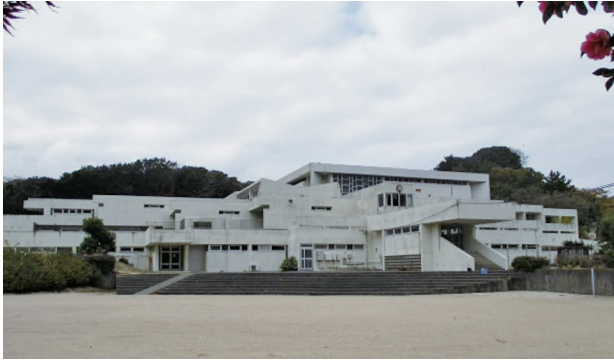
図4 島田幼稚園（小学校も含む全体） グラウンド左手から上がる階段の上の四角い 開口部が幼稚園の玄関
