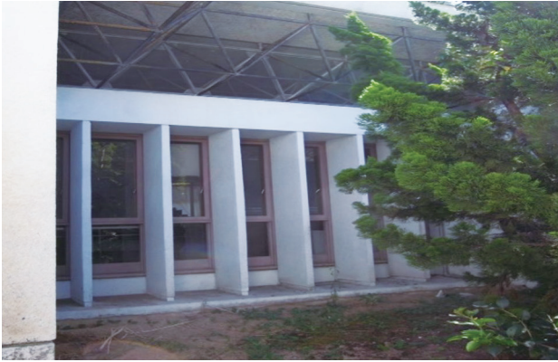
図7 北灘西幼稚園 壁と屋根の接合部分
