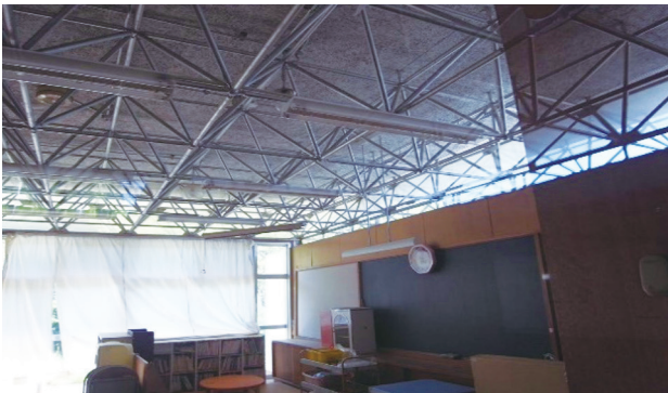
図8 北灘西幼稚園 天井
