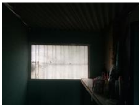
Gambar 8. Jendela di Tangga Sumber : Dokumentasi Pribadi, 2021
