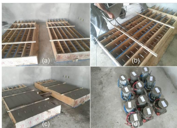
Figura 3: (a) Fôrmas; (b) Concretagem; (c) Vigas concretadas; (d) Corpos de prova.
