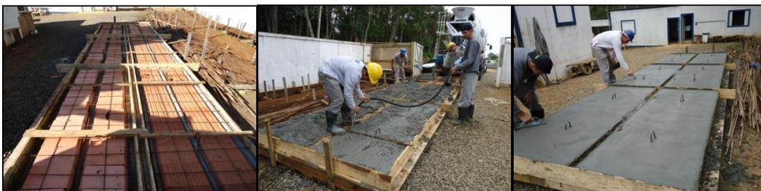
Figura 3. (a)Montagem das formas (b)Adensamento (c)Regularização
