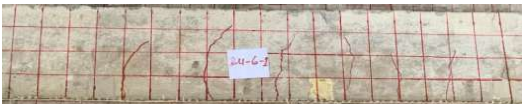
Gambar 15 Pola retak pada balok perkuatan GFRP-S tulangan korosi 6 minggu
