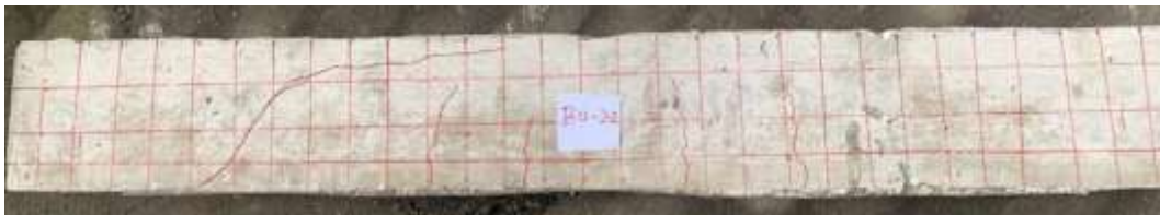
Gambar 13 Pola retak pada balok perkuatan GFRP-S tulangan korosi 2 minggu
