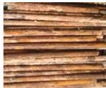
b. Tulangan terkorosi
