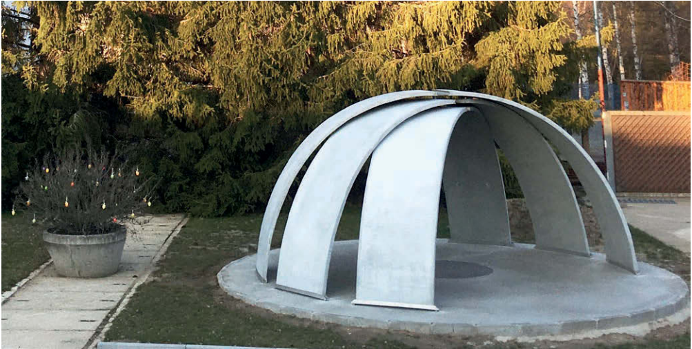
Bild 3: Der Carbonbeton-Schalendemonstrator besteht aus 5 cm dicken doppeltgekrümmten Einzelelementen, die gegeneinander versetzt angeordnet sind | Fig. 3: The carbon reinforced concrete formwork demonstrator consists of 5 cm thick double-curved individual elements that are arranged offset from each other | Source: Roy Lange
