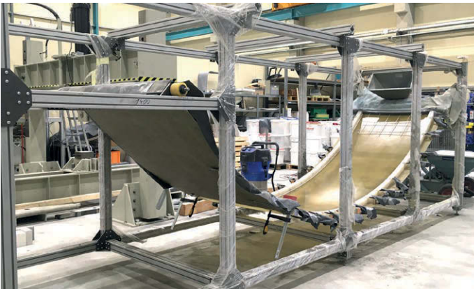
Bild 1: Fertigung der Schalenelemente mittels neuem GFK-Schalungssystems mit flexibel einstellbaren Krümmungszuständen | Fig. 1: Production of the shell elements using a new GRP formwork system with flexibly adjustable curvature states | Source: Christian Müller
