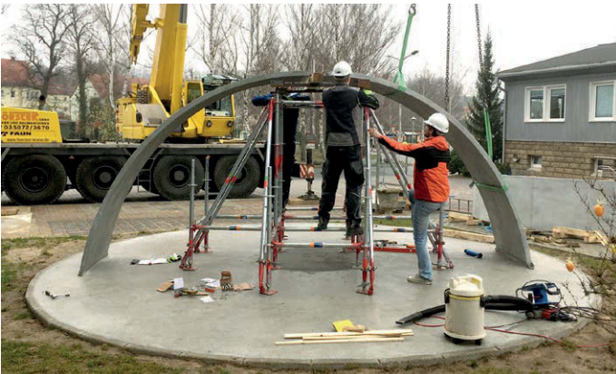
Bild 2: Aufbau des Carbonbeton-Schalendemonstrators auf dem Firmengelände des Projektpartners Betonwerk Schuster GmbH in Cunewalde | Fig. 2: Construction of the carbon reinforced concrete formwork demonstrator on the company premises of the project partner Betonwerk Schuster GmbH in Cunewalde | Source: Christian Müller
