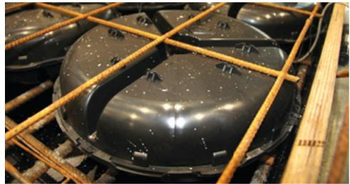
**Bild 22:** Detail Hohlkörper cobiax® Slim-Line S-100 (oben), Hohlkörper nach Einbau (unten) | **Fig. 22:** Detail cobiax® S-100 void former (top), void former after assembly (bottom)
