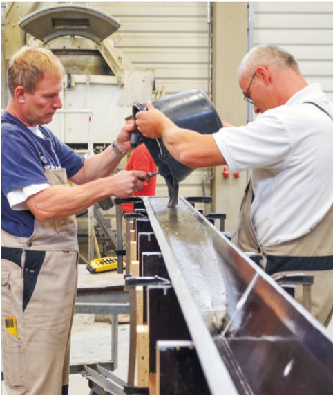
Bild 4: Betonage einer dreieckigen Stütze | Fig. 4: Concreting of a triangular column
