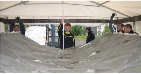
Bild 15: Arbeitsschritte bei der Herstellung von Tonnenschale II: Annäherung der Form durch Hängen (links); Wenden der Struktur (rechts) | Fig. 15: Steps during the construction process of barrel vault II: approximation of the form in a hanging state (left); turning (right)
