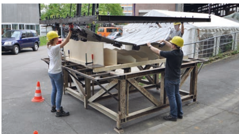
Bild 17: Canopy-Faltnetzwerk: Faltnetzprozess durch Hängen (links); Ansicht fertige Schale (rechts) | Fig. 17: Canopy shell: folding process by hanging (left); view of finished structure (right)
