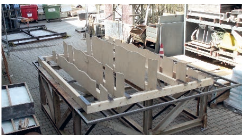
Bild 14: Faltung der Tonnenschale I: Spantenkonstruktion (links) und Faltung des Halbzeuges durch Ablassen auf die Spantenkonstruktion (rechts) | Fig. 14: Folding process of barrel vault I: scaffolding (left); folding of the oricrete plate by use of the scaffolding (right)
