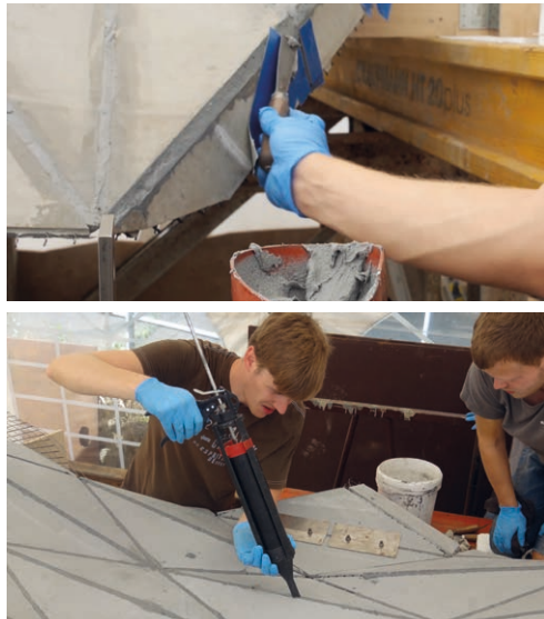
Bild 9: Einbringen des Mörtels in die Faldfuge: händischer Einbau (oben) und Einbau mit Mörtelspritze (unten) | Fig. 9: Pouring of grout into folding edges: manual installation (top) and installation with mortar caulking gun (bottom)
