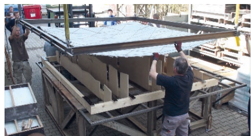
Bild 14: Faltung der Tonnenschale I: Spantenkonstruktion (links) und Faltung des Halbzeuges durch Ablassen auf die Spantenkonstruktion (rechts) | Fig. 14: Folding process of barrel vault I: scaffolding (left); folding of the oricrete plate by use of the scaffolding (right)
