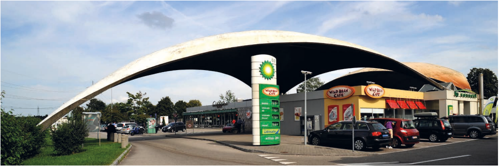
Bild 4: Raststätte Deitingen Süd von Heinz Isler in der Schweiz | Fig. 4: Highway service area Deitingen south by Heinz Isler in Switzerland
