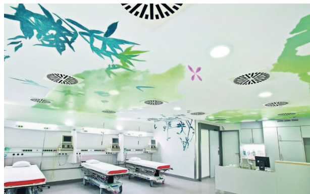
Abb. 5: Überwachungsbereich der Robert-Bosch-Krankenhaus, Stuttgart, 2011, MarkusWeggenmann [18]
