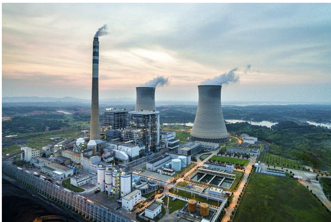
Abbildung 14: Modernes Kraftwerk in Europa © iStock.com/zhongguo
